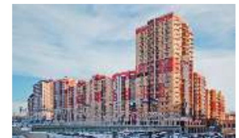
ЖК «Солнечный город», Казань «АК БАРС Строй»
